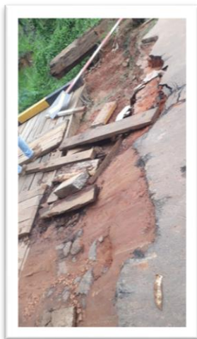
Figura 1 – Reparos na cabeceira da ponte.
