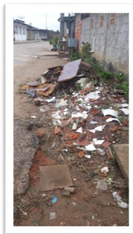
Figura 2 – Limpeza e construção de calçadas.
