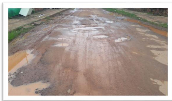
Figura 1 – Pavimentação de via pública.
