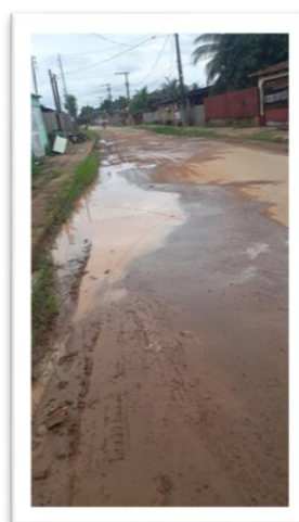
Figura 2 – Pavimentação de via pública.
