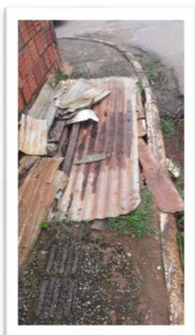
Figura 1 – Tapa de bueiro.
