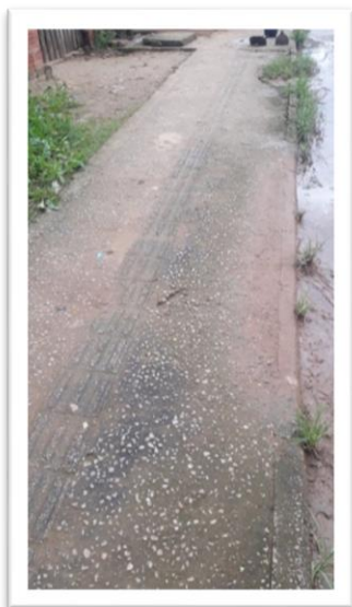
Figura 1 – Pintura de rampa.
