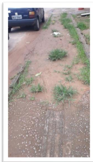
Figura 2 – Recuperação de calçamento.
