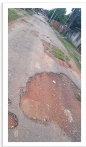
Figura 1 – Pavimentação de via pública.
