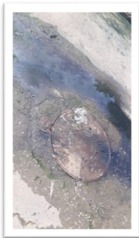
Figura 1 – Desobstrução de bueiro.
