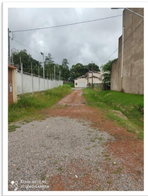
Figura 1 – Pavimentação de via pública.
