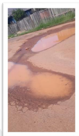
Figura 2 – Pavimentação de via pública.
