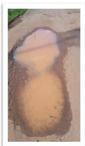
Figura 1 – Pavimentação de via pública.
