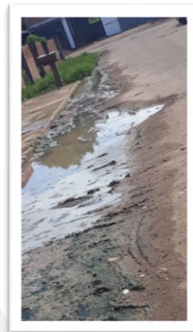
Figura 2 – Pavimentação de via pública.
