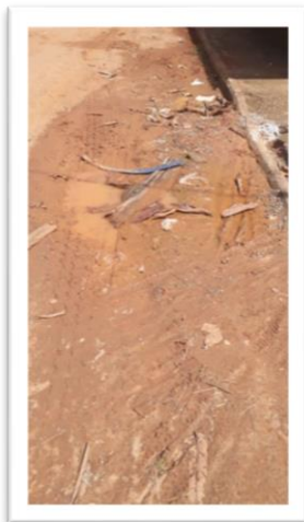
Figura 1 – Pavimentação de via pública.
