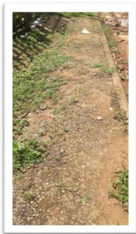
Figura 1 – Reconstrução de calçada.
