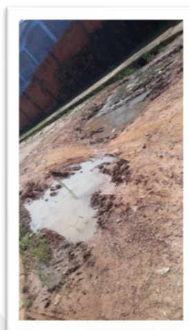
Figura 2 – Pavimentação de via pública.
