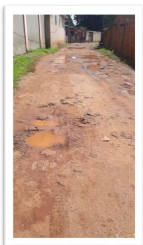
Figura 1 – Pavimentação de via pública.
