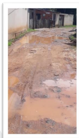
Figura 2 – Pavimentação de via pública.
