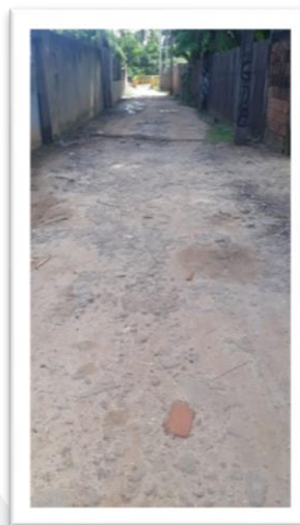
Figura 2 – Pavimentação de via pública.
