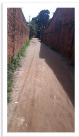
Figura 1 – Pavimentação de via pública.
