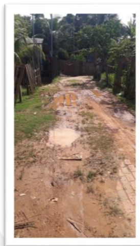
Figura 2 – Pavimentação de via pública.
