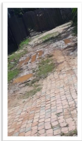
Figura 1 – Pavimentação de via pública.
