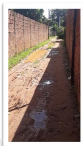
Figura 2 – Pavimentação de via pública.
