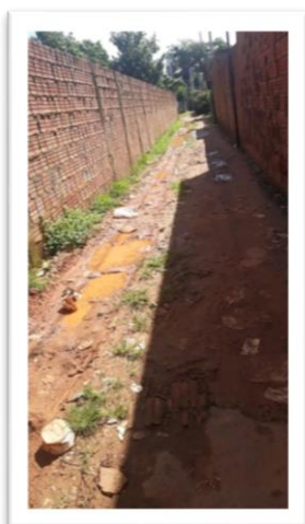
Figura 1 – Pavimentação de via pública.
