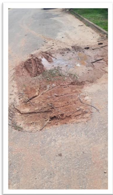
Figura 1 – Pavimentação de via pública.
