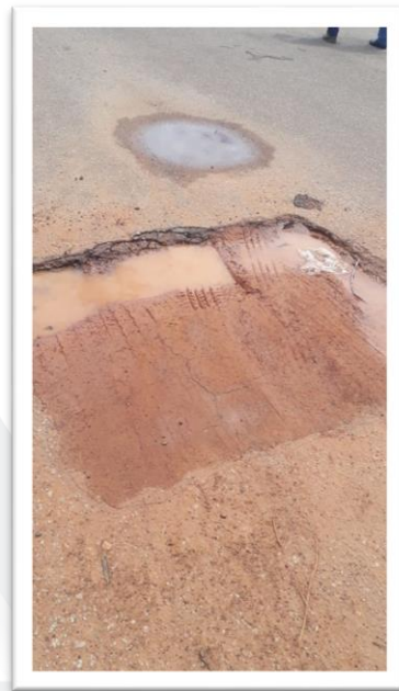
Figura 2 – Pavimentação de via pública.
