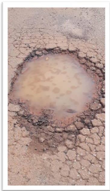
Figura 1 – Pavimentação de via pública.
