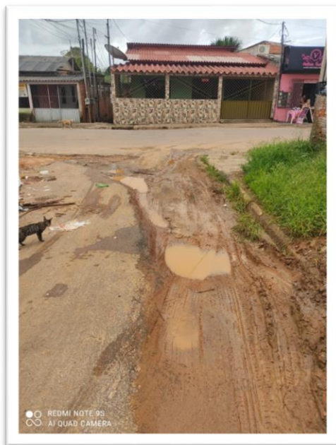
Figura 1 – Pavimentação de via pública.
