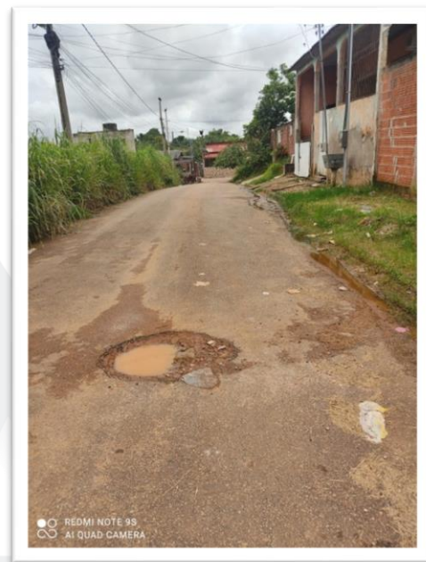
Figura 2 – Pavimentação de via pública.
