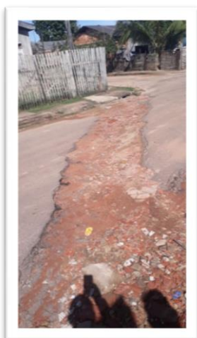
Figura 1 – Pavimentação de via pública.
