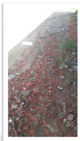
Figura 2 – Pavimentação de via pública.
