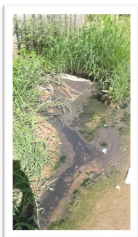
Figura 1 – Desobstrução de bueiro.
