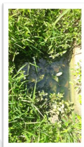
Figura 2 – Desobstrução de bueiro.
