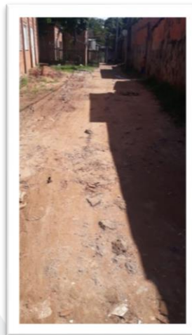
Figura 2 – Pavimentação de via pública.
