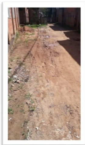
Figura 1 – Pavimentação de via pública.
