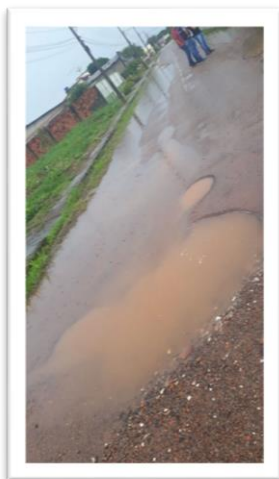
Figura 1 – Pavimentação de via pública.
