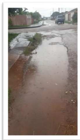
Figura 2 – Pavimentação de via pública.
