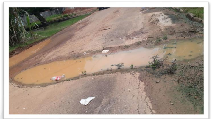
Figura 2 – Pavimentação de via pública.
