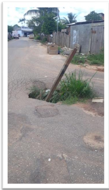
Figura 1 – Pavimentação de via pública.
