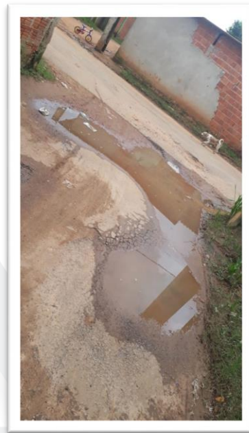
Figura 2 – Pavimentação de via pública.
