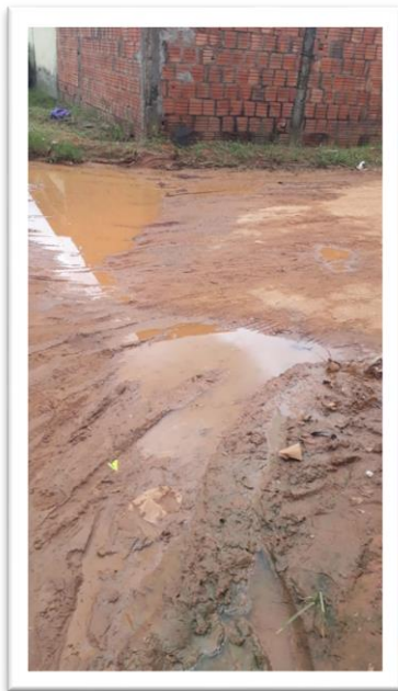
Figura 1 – Pavimentação de via pública.
