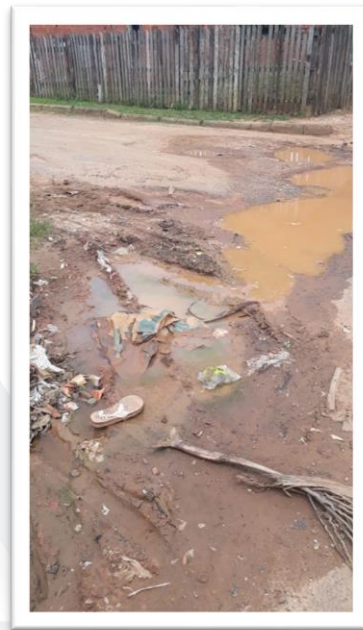
Figura 2 – Pavimentação de via pública.
