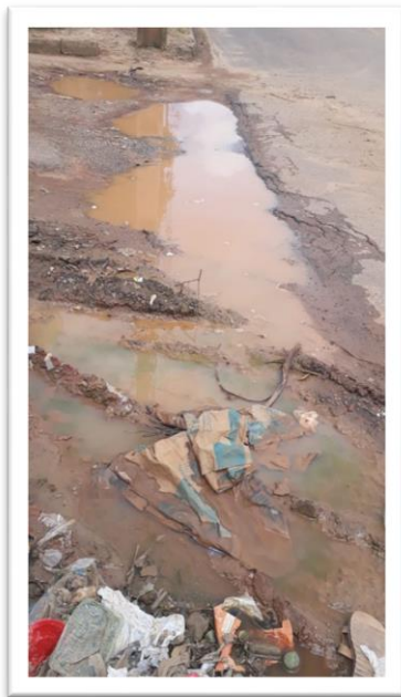
Figura 1 – Pavimentação de via pública.
