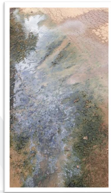
Figura 2 – Desobstrução de bueiro.
