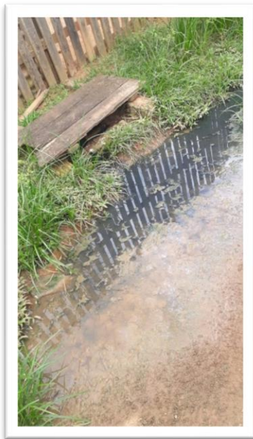
Figura 1 – Desobstrução de bueiro.
