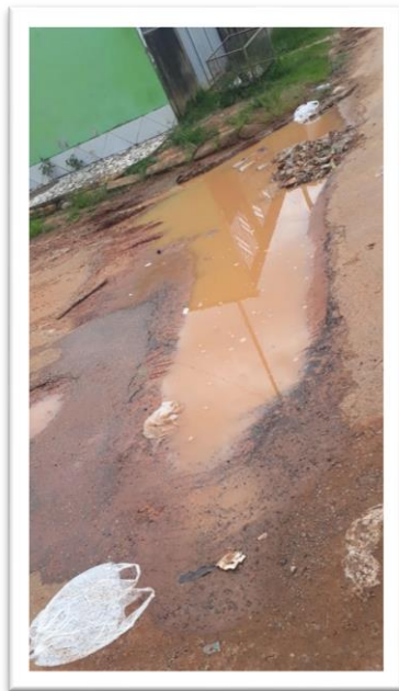
Figura 1 – Pavimentação de via pública.
