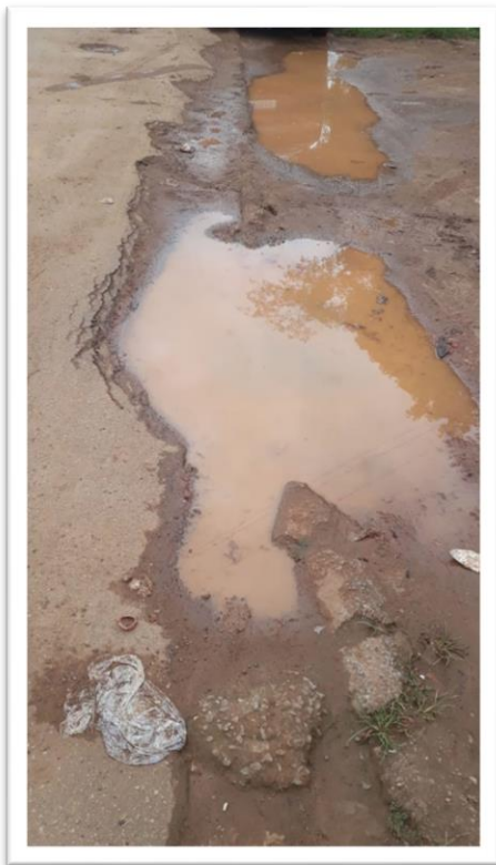
Figura 1 – Pavimentação de via pública.
