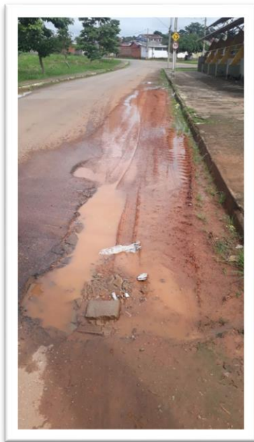
Figura 1 – Pavimentação de via pública.
