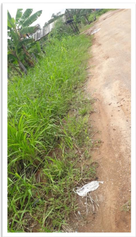
Figura 1 – Limpeza de via pública.
