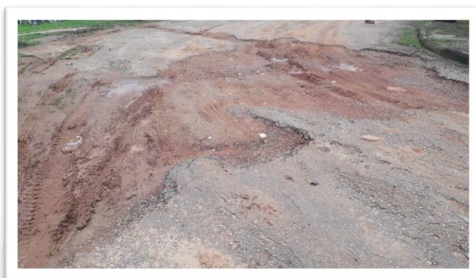
Figura 2 – Pavimentação de via pública.
