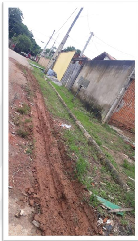
Figura 2 – Pavimentação de via pública.
