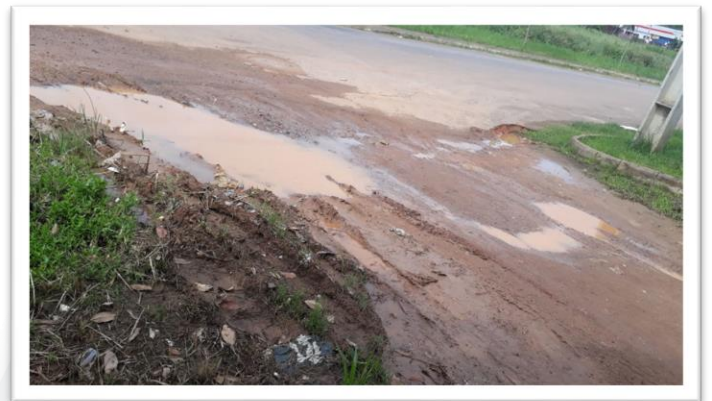
Figura 2 – Pavimentação de via pública.
