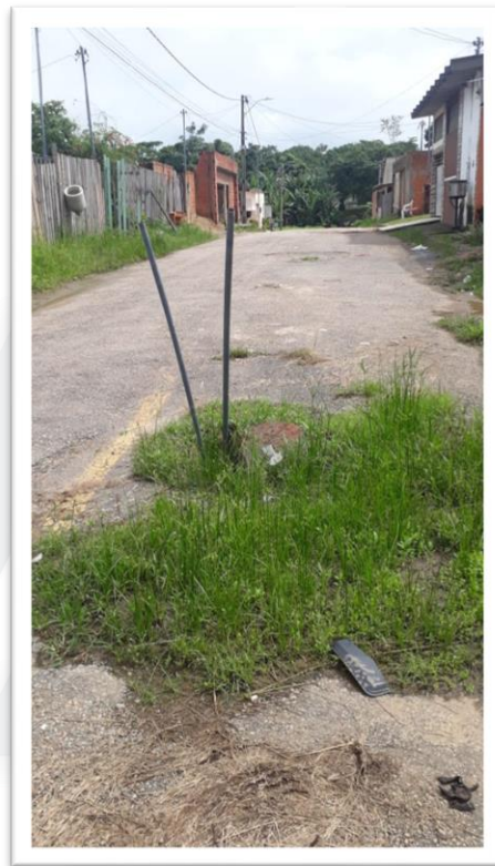
Figura 2 – Pavimentação e limpeza de via pública.
