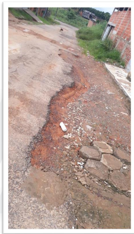
Figura 2 – Pavimentação de via pública.
