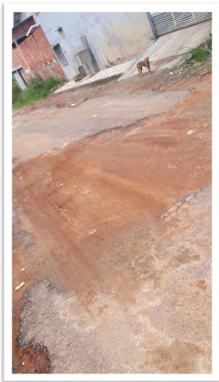
Figura 1 – Pavimentação de via pública.
