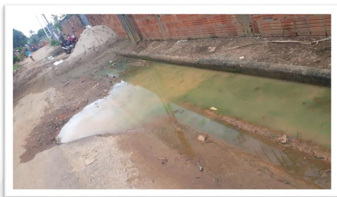
Figura 2 – Pavimentação de via pública.
