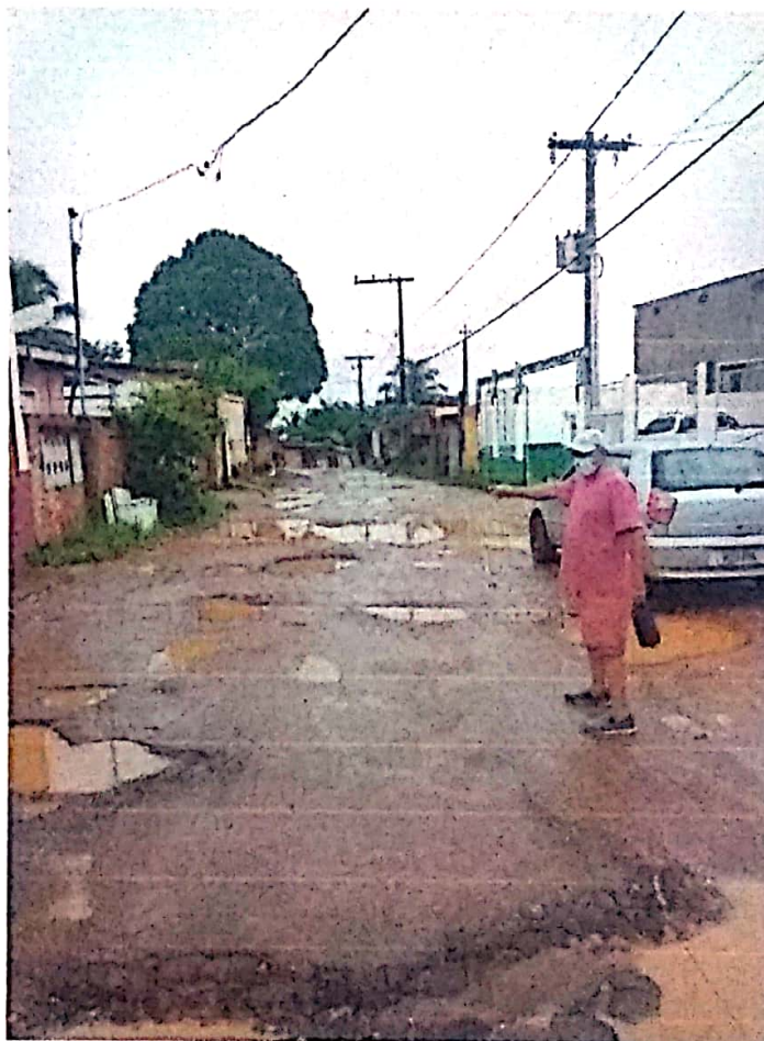
Figura 2 – Rua com vários buracos.
