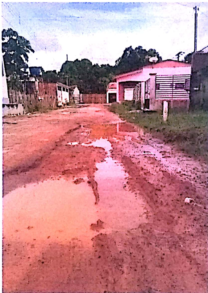
Figura 2 – Buraco acumulando poça de lama de aproximadamente 5 metros de extensão.
