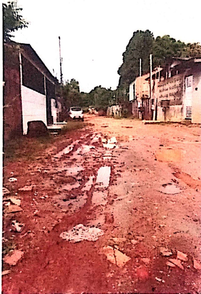
Figura 2 – Rua sem pavimentação.
