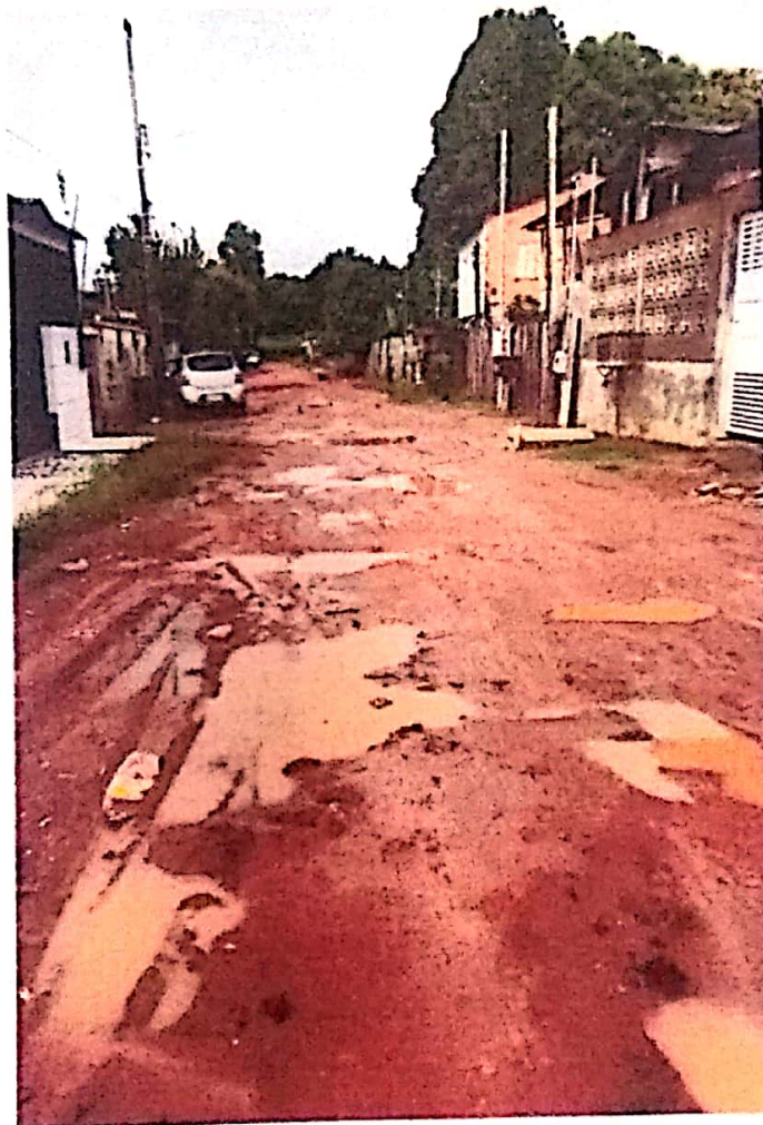
Figura 3 – Rua sem pavimentação, com vários pontos de água da chuva represada.
