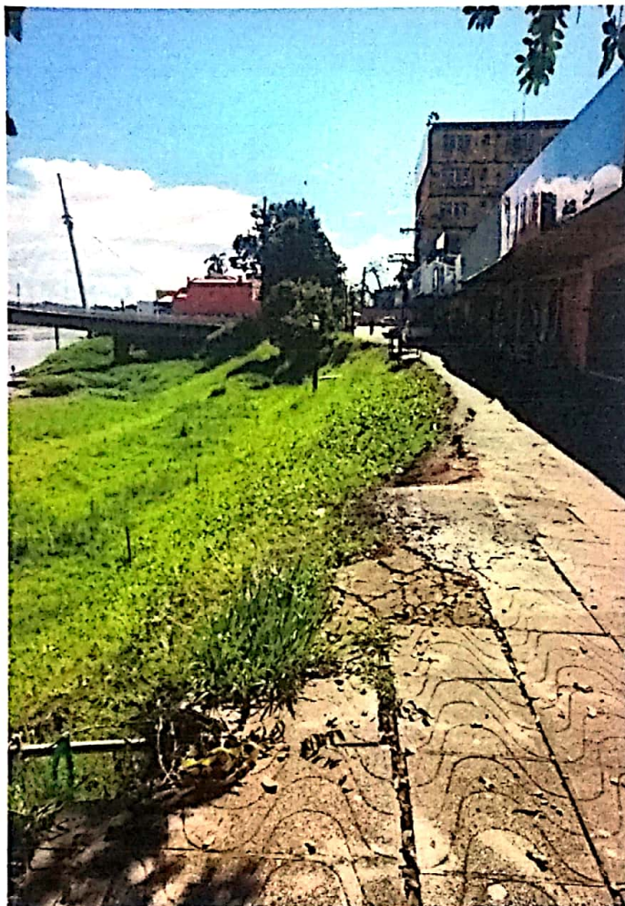
Figura 4 – Área de desbarrancamento de mais de 20 metros de extensão.
