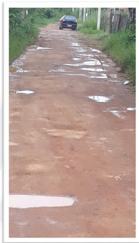
Figura 2 – Pavimentação de via pública.
