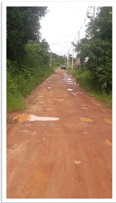
Figura 1 – Pavimentação de via pública.
