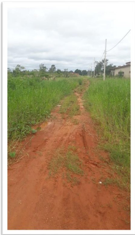
Figura 1 – Pavimentação de via pública.
