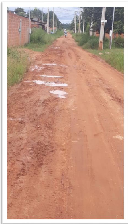
Figura 1 – Pavimentação de via pública.
