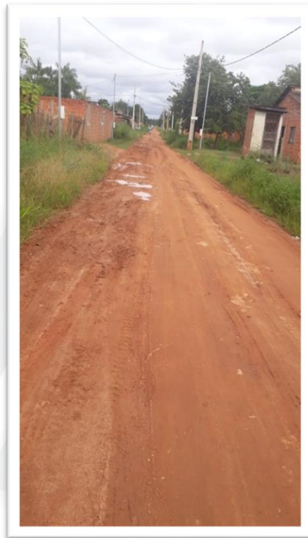
Figura 2 – Pavimentação de via pública.
