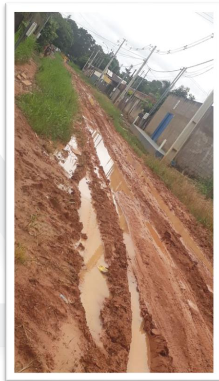
Figura 2 – Pavimentação de via pública.
