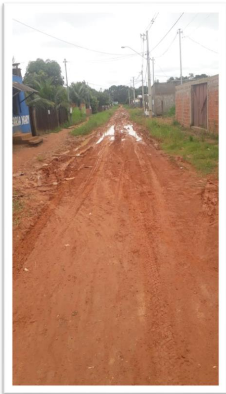
Figura 1 – Pavimentação de via pública.
