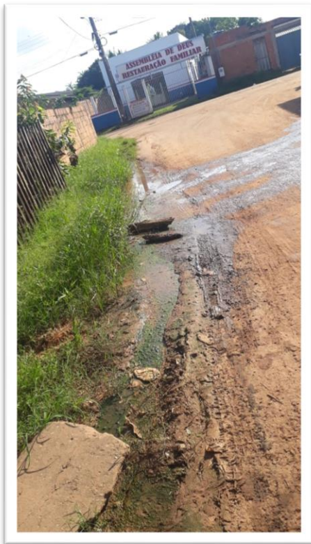
Figura 1 – Esgoto em via pública.
