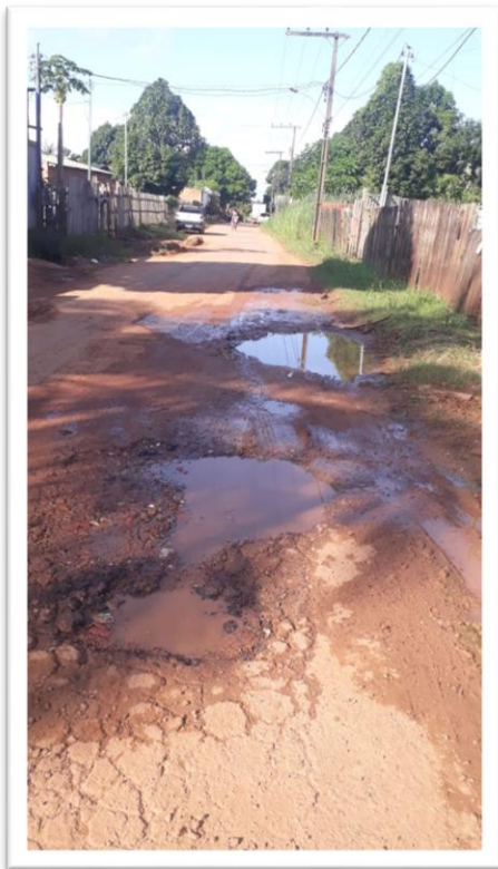
Figura 1 – Pavimentação de via pública.
